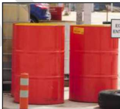
Container για την προσωρινή αποθήκευση ηλεκτρικών συσσωρευτών μολύβδου-θειικού οξέος
