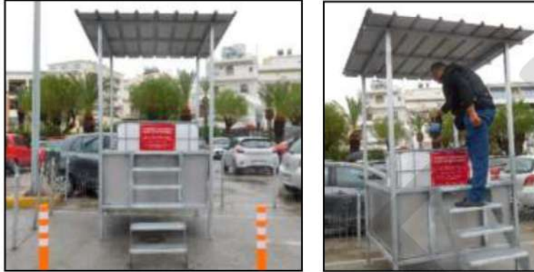
Δεξαμενές με στέγαστρο και λεκάνη ασφαλείας με σκαλοπάτια
